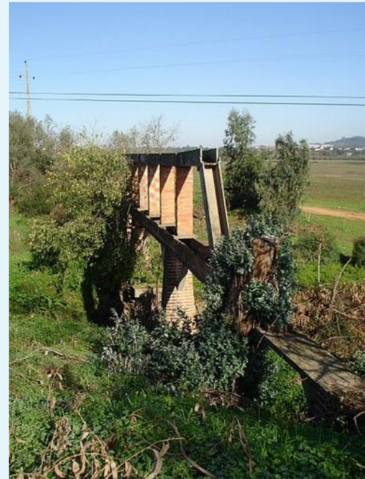
Aqueduto para Rega
