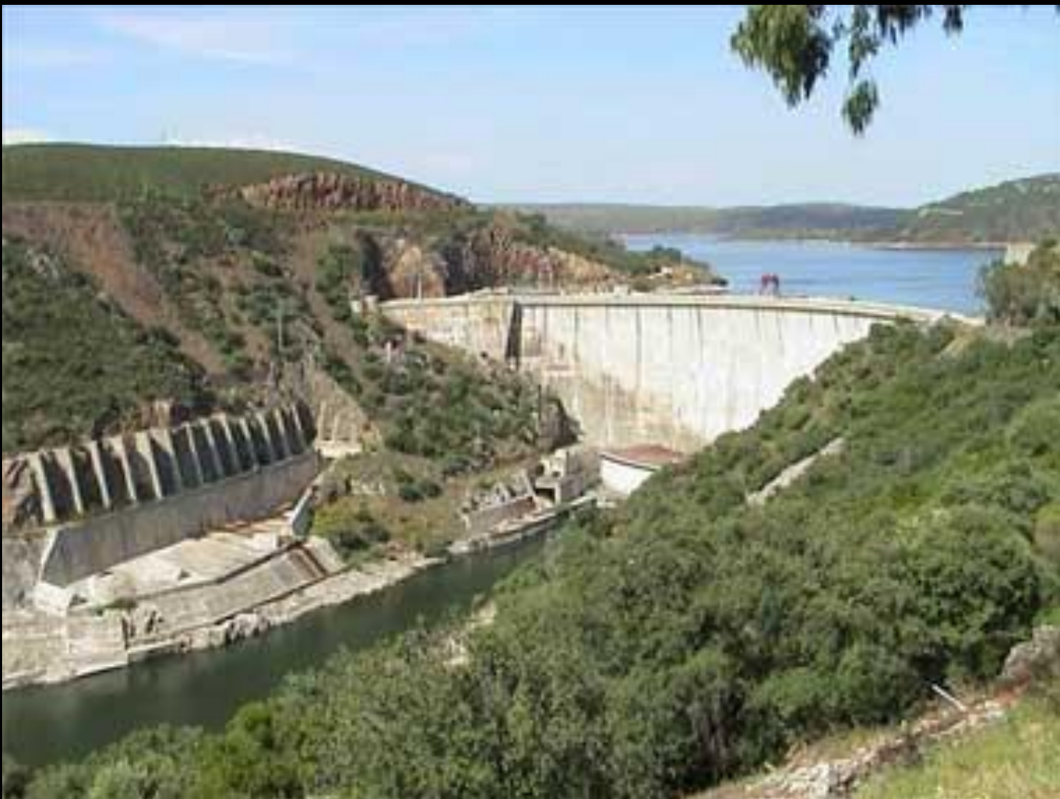
PRESA DE VALDECAÑAS
